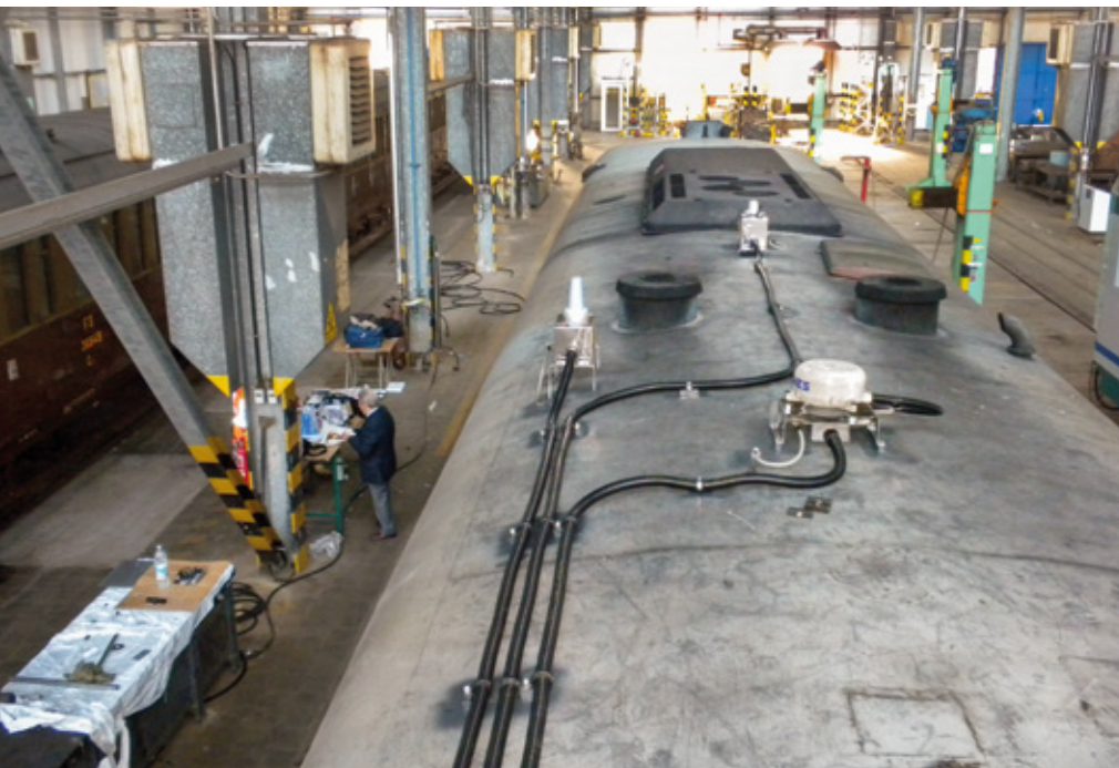
Complesso delle antenne per la ricezione dei segnali satellitari appena installate sul tetto dell'automotrice ALn 668.3114 (foto RFI, 21 novembre 2014).
